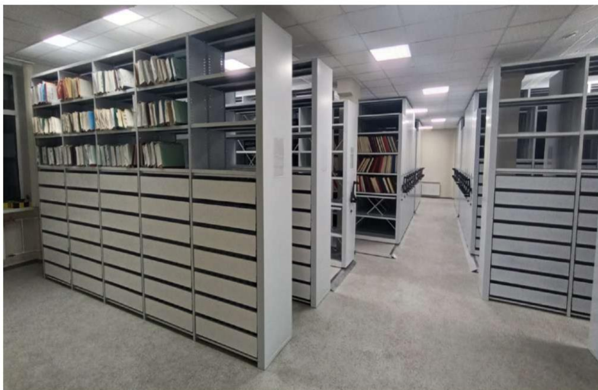
Установка новых стеллажных систем в специальном помещении
