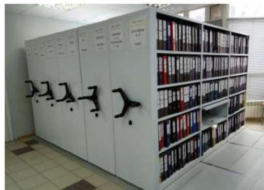
Установленный стеллажи с фальшполом
